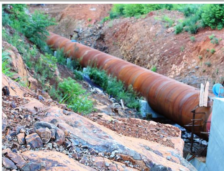
Figura 04: Escavações para implantar o Conduto Forçado
