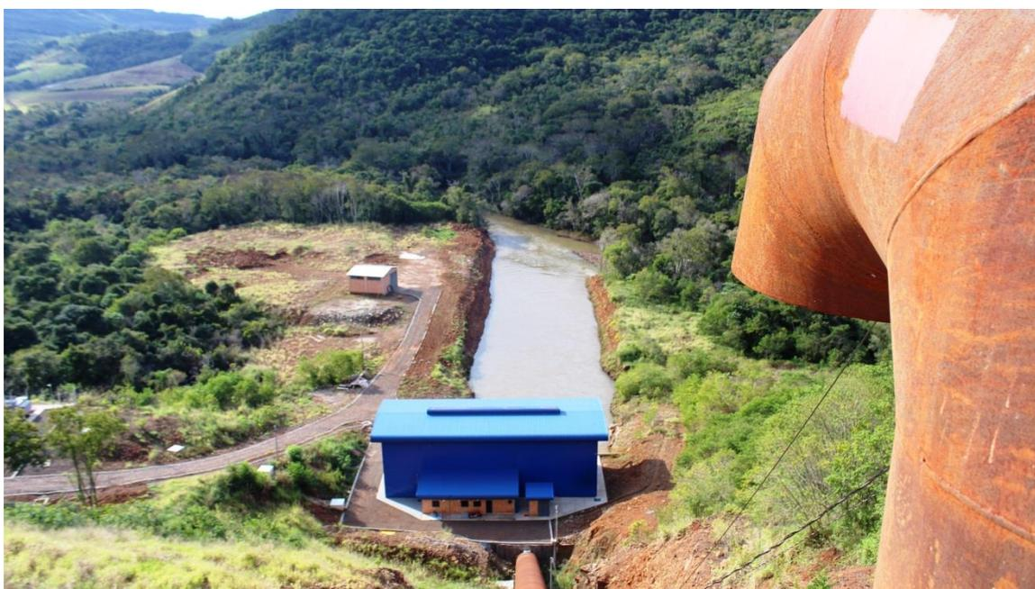
Fig 15: Vista panorâmica Ponto 03: Conduto Forçado e Casa de Força em 2014
