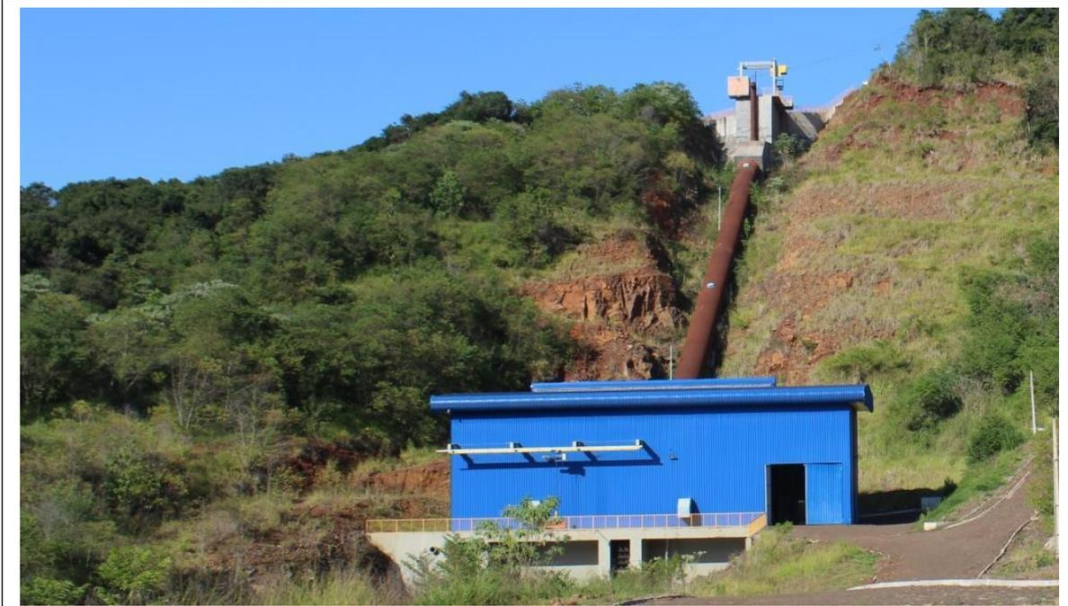
Figura 04: Conduto Forçado, Casa de Força e, a esquerda, área de Compensação Legal
