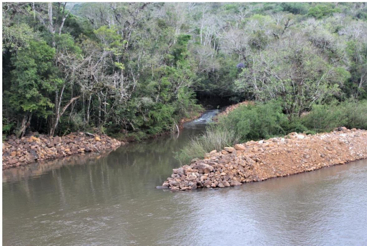
Fig.07. Ajuste no final do TVR, no encontro com o Canal de Restituição, para melhorar o fluxo hídrico.
